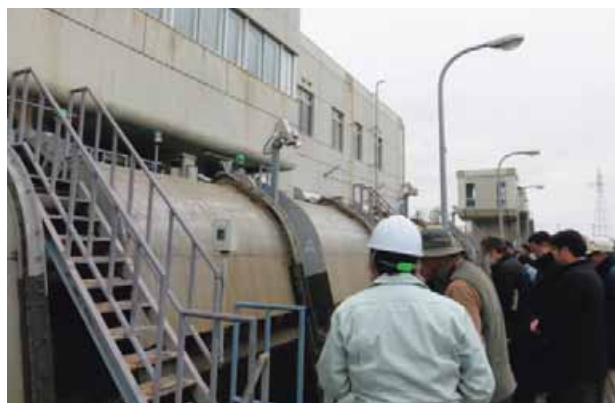
新井郷川排水機場の除塵機を見学
