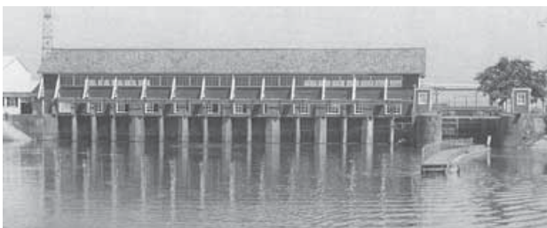
図-27 栗ノ木川排水機場(出典：写真は語る亀田の百年)
