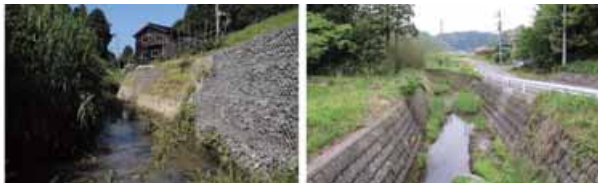
図 39. 河川改修が迫るイシガメ生息地 左) 新たな工事計画があるブロック護岸や蛇籠護岸の川 右) 近くのイシガメが住めない三面護岸の川
