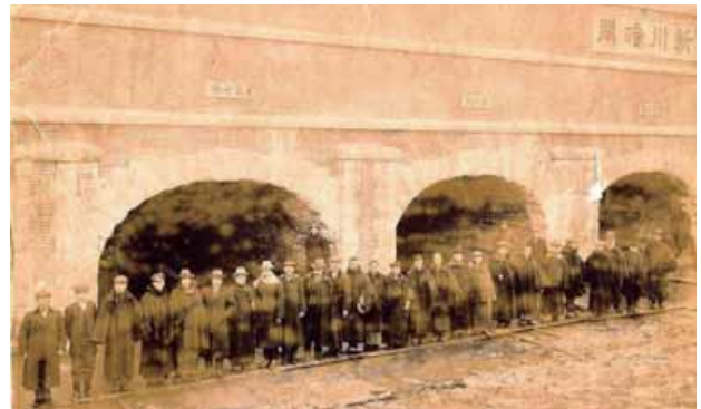
図-25 完成した新川暗閘(出典：西蒲原土地改良区)
