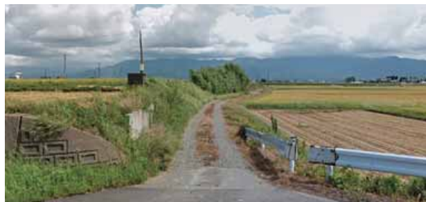
図 11. 旧河道Ⅱのその段差
