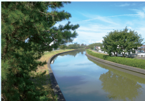
■図-19 西川（西区開新橋より）
