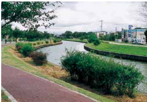
■図-19 西川 (清掃事務所付近)
