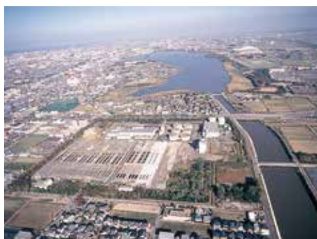
■図-20 中部下水処理場
