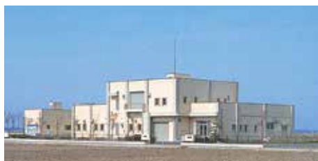
■図-21 新潟市両川浄化センター
