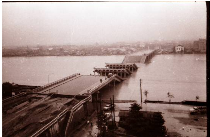
写真 1-1.1 新潟地震による被害
