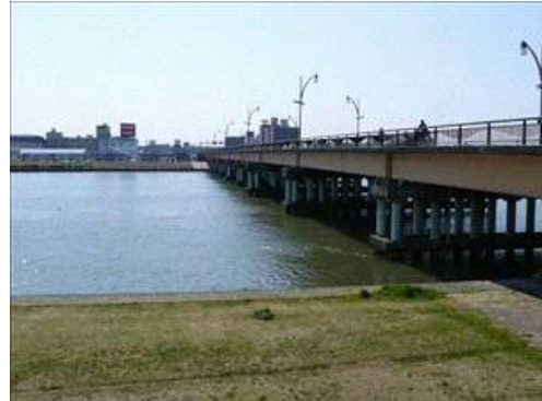
写真 2-5.1 パイルベント橋脚の例（昭和大橋）
