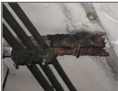
附属物取付部の腐食を確認する新技術
