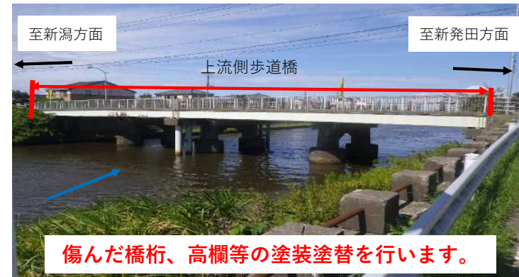
上流側から撮影
