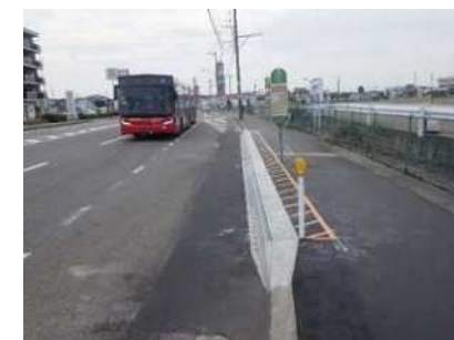
小新四丁目バス停 バリアレス縁石設置 令和4年8月
