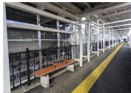
青山結節点上屋改良 令和3年12月
