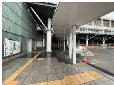
新潟駅南口広場 バス停留所上屋整備 令和4年12月
