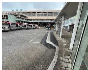
新潟駅南口広場バス停 バリアレス縁石設置 令和5年3月（予定）
