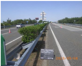
ある日の作業現場
