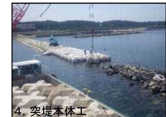
4. 突堤本体工 (海岸コンクリートブロック据付)
