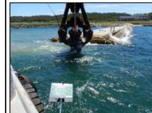
3. 突堤本体工(捨石投入)
