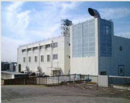
西川排水機場の全景
