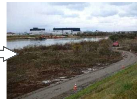
R1伐採箇所(伐採後)
