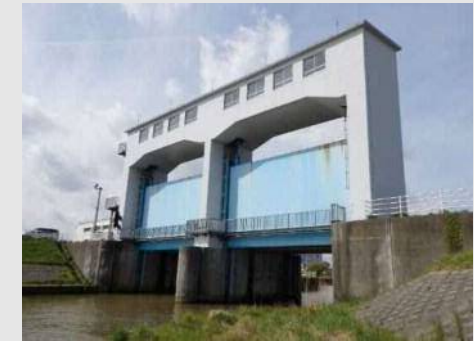
西川水門の全景
