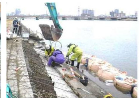
護岸補修作業
