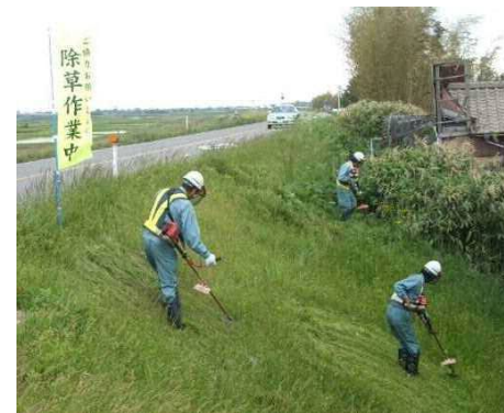
堤防除草(肩掛け式草刈り機)
