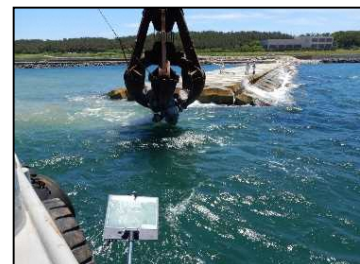
3. 突堤本体工(捨石投入)
