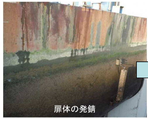
新潟大堰主ゲート2号塗替塗装
