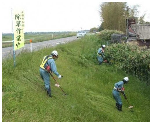
堤防除草(肩掛け式草刈り機)
