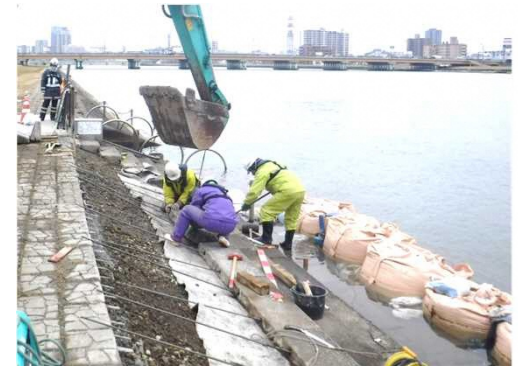
護岸補修作業
