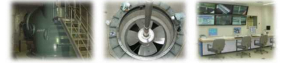
新潟大堰閘門下流ゲート開閉装置更新(ワイヤーフ式からチェーンラック式)
