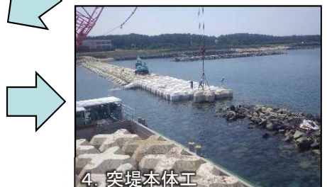
4. 突堤本体工 (海岸コンクリートブロック据付)
