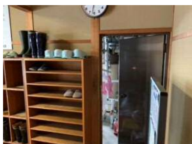
玄関から機械室
