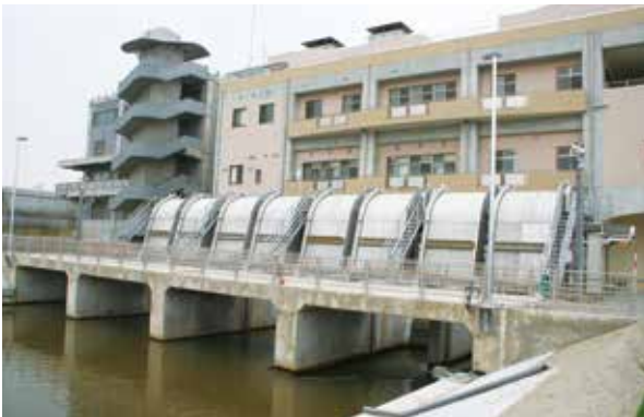
親松排水機場
