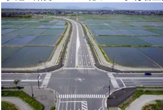
新潟中央環状道路 横越バイパス
