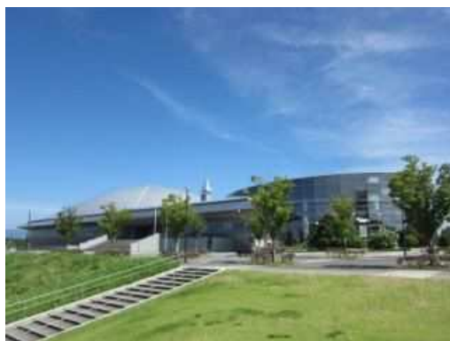
亀田総合体育館
