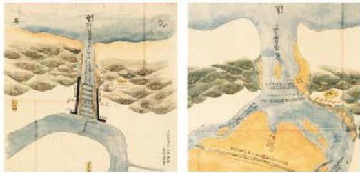
完成した掘割
