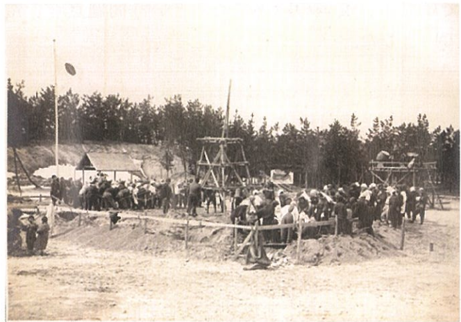
写真2 地固めの様子
