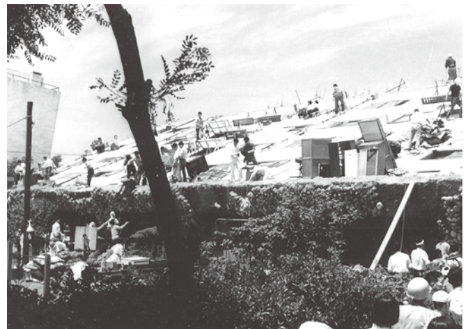
写真3 横倒しになった川岸町の県営アパート
