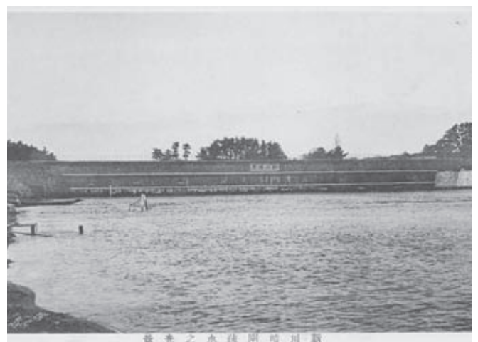
写真3 完成後の新川暗閘
