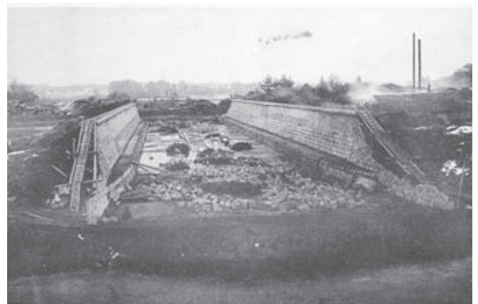
写真2 工事中の新川暗閘上部
