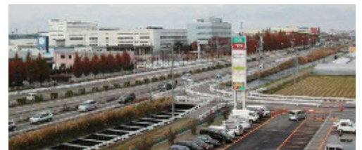
亀田バイパス沿いの排水路と左に見える工業団地
