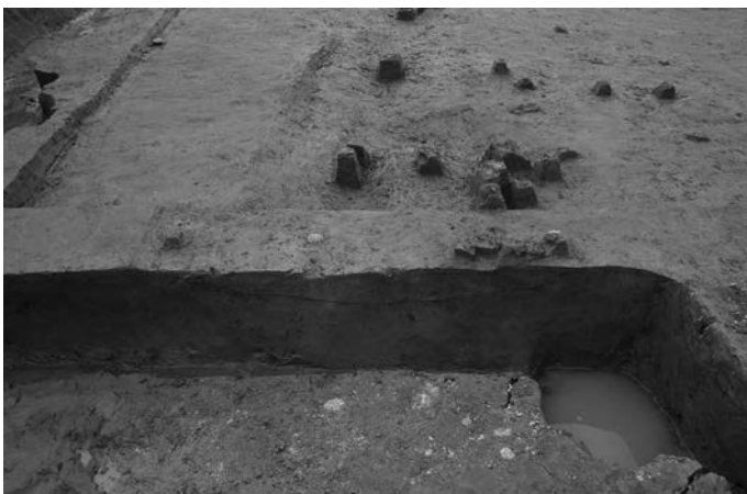
中央部 SU2 土層断面 (南東から)
