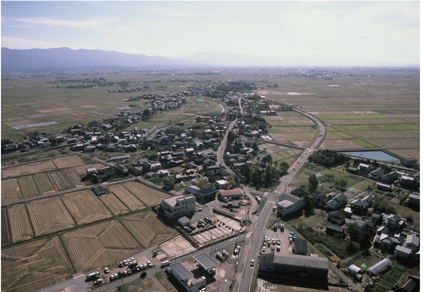
調査地遠景 1 (北西から)
