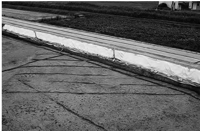
10区SD4～9 完掘(北東から)
