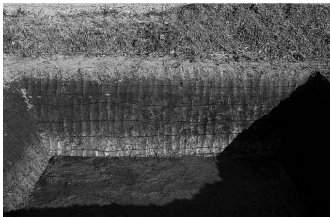
24次 4区-7 基本層序（北西から）
