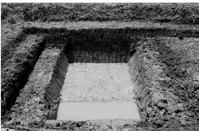
24次 4区-6 完掘状況（北西から）
