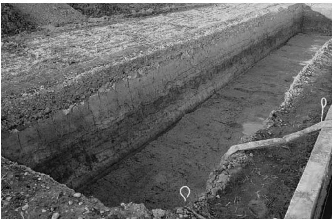
19次 5区東 -13 完掘状況 (南から)
