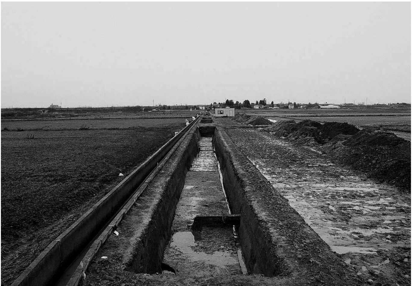
19次 5区東 完掘状況（北東から）
