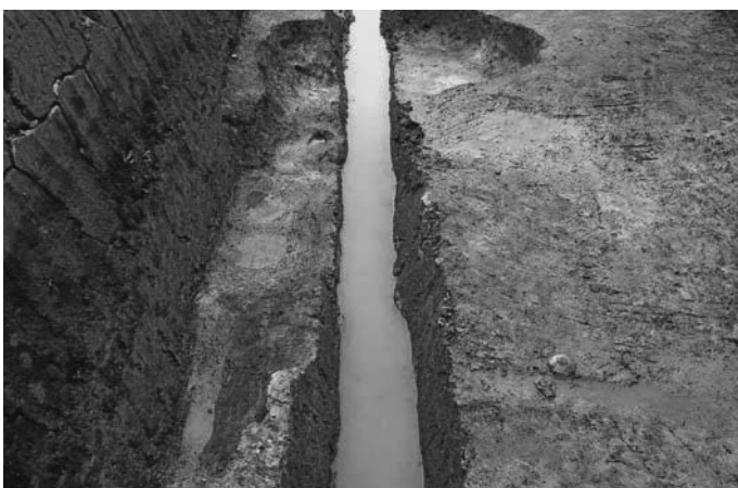
22次 3区 SX117 完掘状況 (南から)
