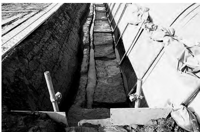
第6次調査区 (D-3I-7C3 ~ 8D3) 完掘（南東から）
