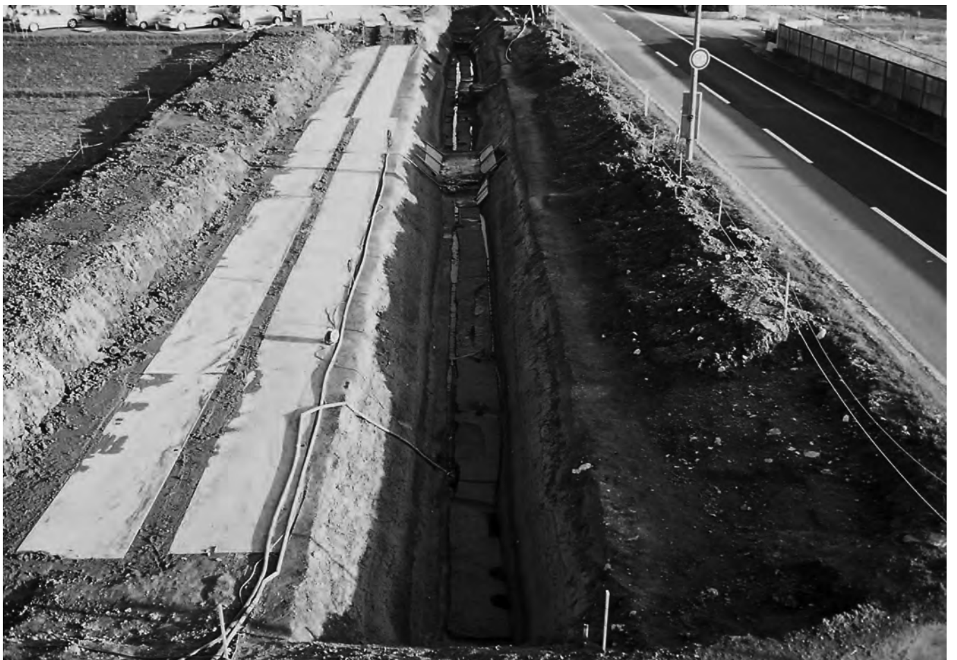
3区 下層 完掘状況 (北東から)
