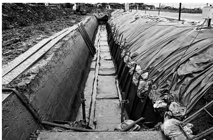
第6次調査区 (D-3I-4J2 ~ 5A8) 完掘（南東から）
