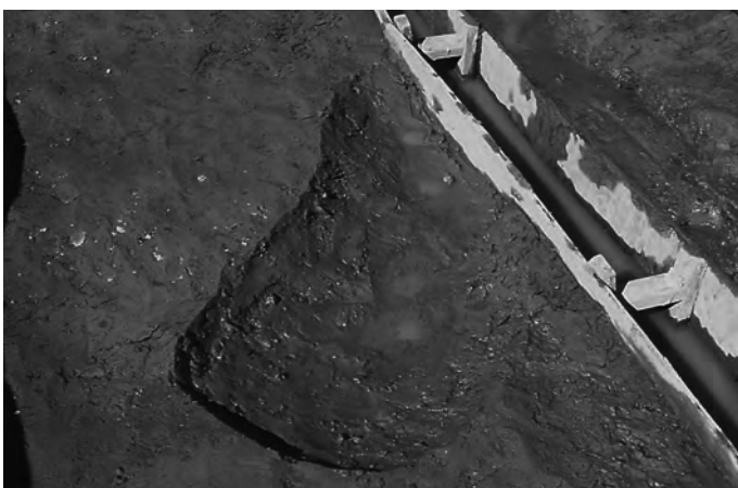
1区 SD55 完掘(北から)
