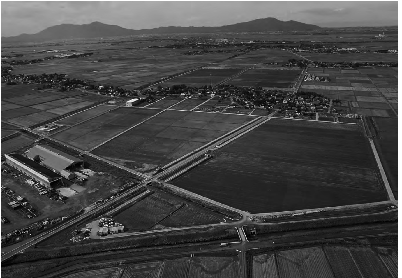
完掘状況（東から）
