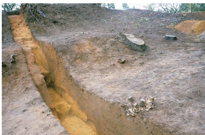
7 12T 墳丘下段斜面～周濠 SD1707 断ち割り (南西から)
