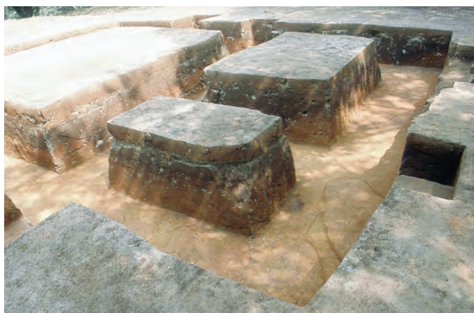
4 墳頂部 測定所基礎部分（北西から）
