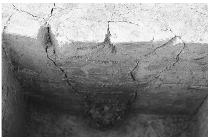
SB1574 P3 土層断面 (東→西)
