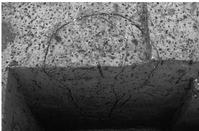
SB4 主軸柱 Pit473 土層断面 (南東→北西)
