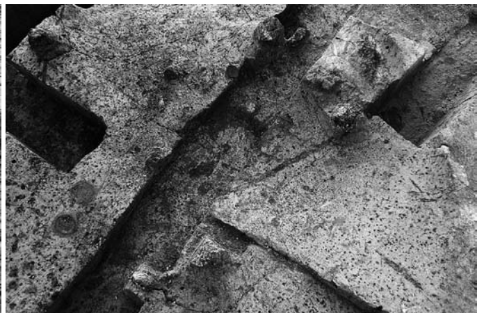
SK722 上面 アスファルト検出状況 (北→南)
