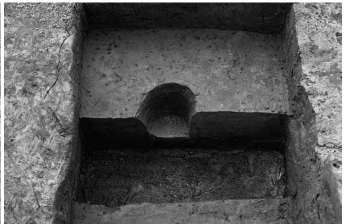
側柱 Pit540 下部完掘 (北→南)
