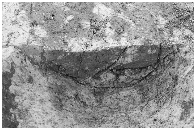
SX761 土層断面 (北東→南西)
