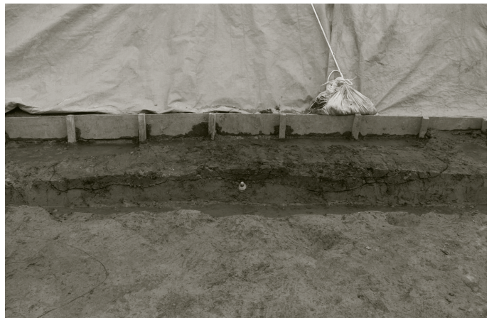
SK79 土層断面（南西から）
