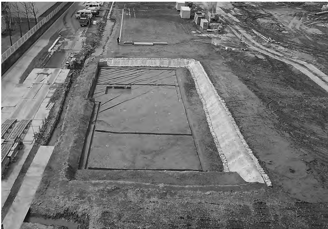
南東隅調査区全景空中写真（東北東から）
