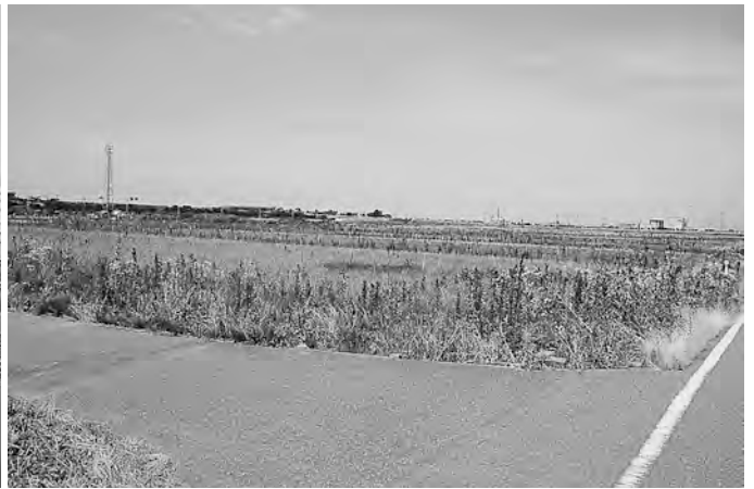
調査前近景 (南側)
