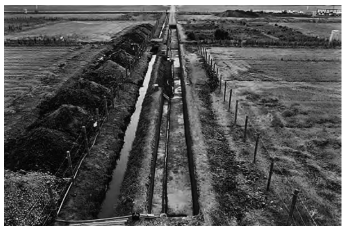
2区 完掘状況 (北東→南西)
