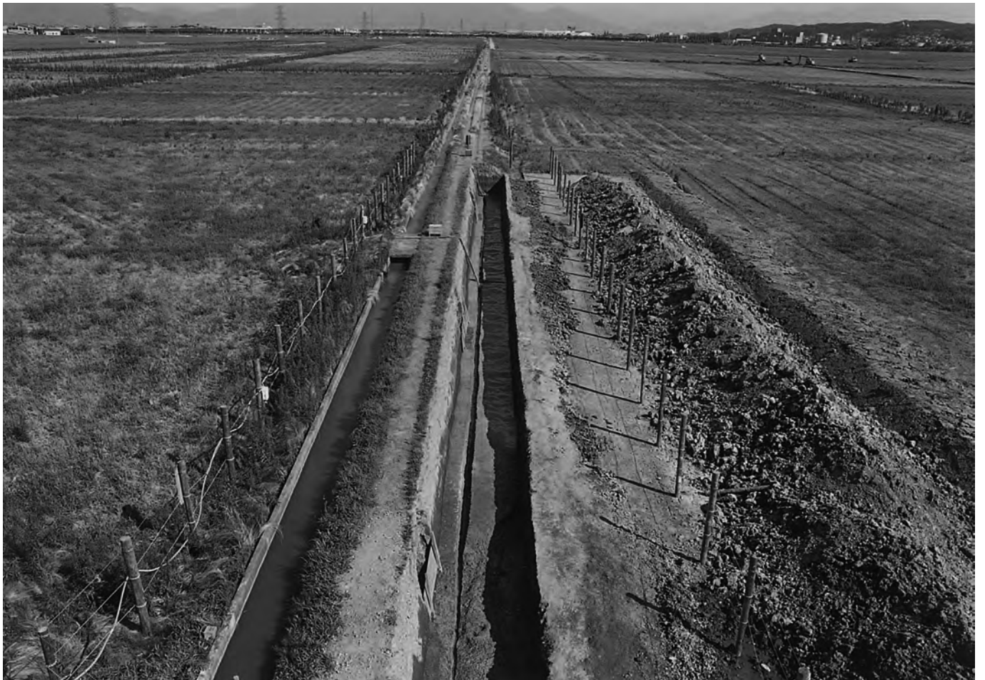
4区 完掘状況 (北西→南東)
