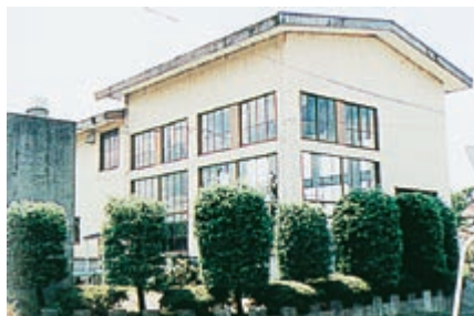
図158 旧味方排水機場
