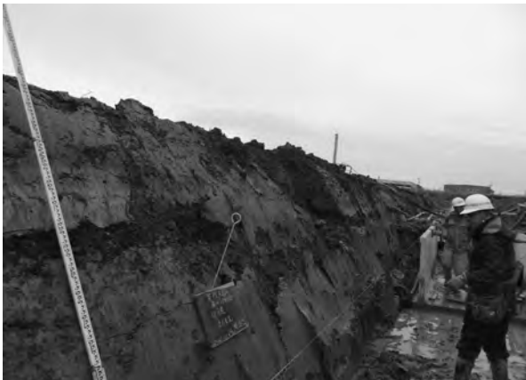
工事立会風景 (茶院A遺跡 2021223)
