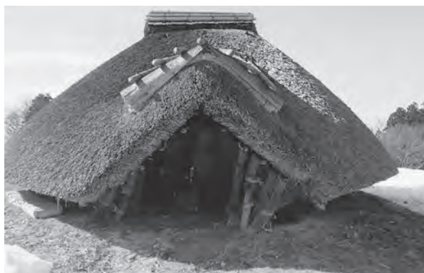
毀損した復元竪穴住居
