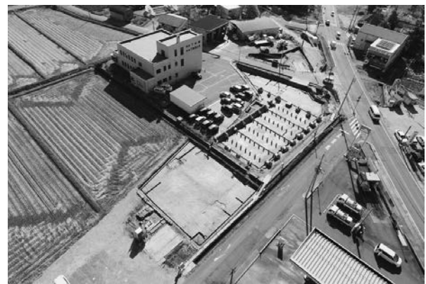
調査区全景 (北から)
