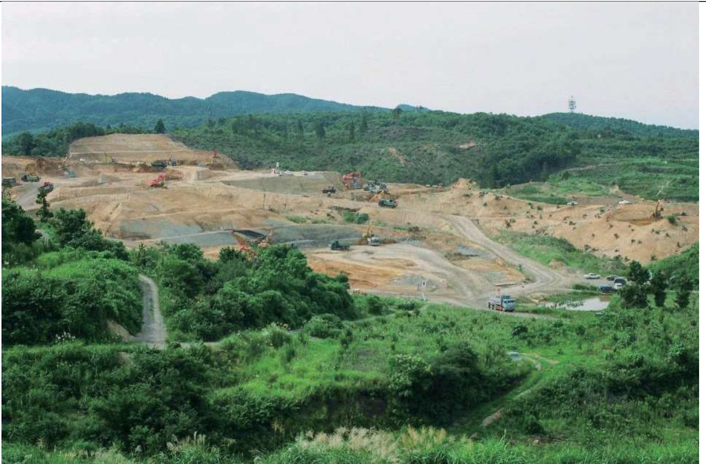
植物園予定地周辺の土取り工事
