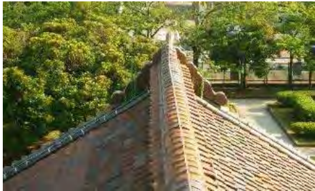
写真 1-23 棟と鬼瓦のずれ
