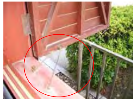
写真1-8 窓のあおり止めの補修
