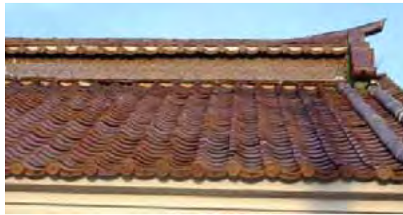
写真 1-22 棟の破損
