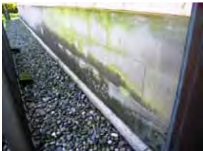
写真 1-16 基礎布石の欠損補修箇所
