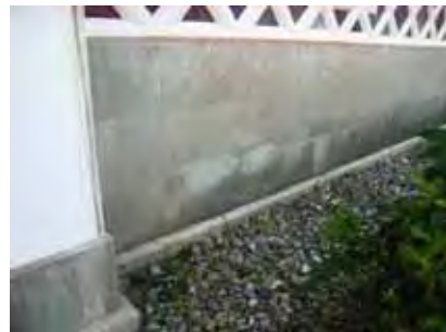
写真 1-17 基礎布石の欠損補修箇所
