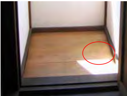
写真1-5 床板の反り
