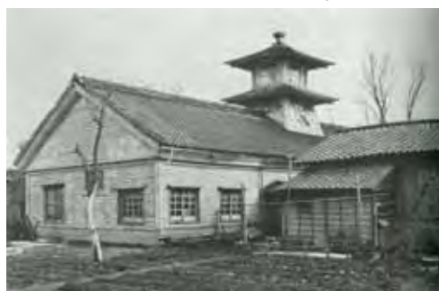
写真 1-1 修理前北西面[昭和 45(1970)年]
