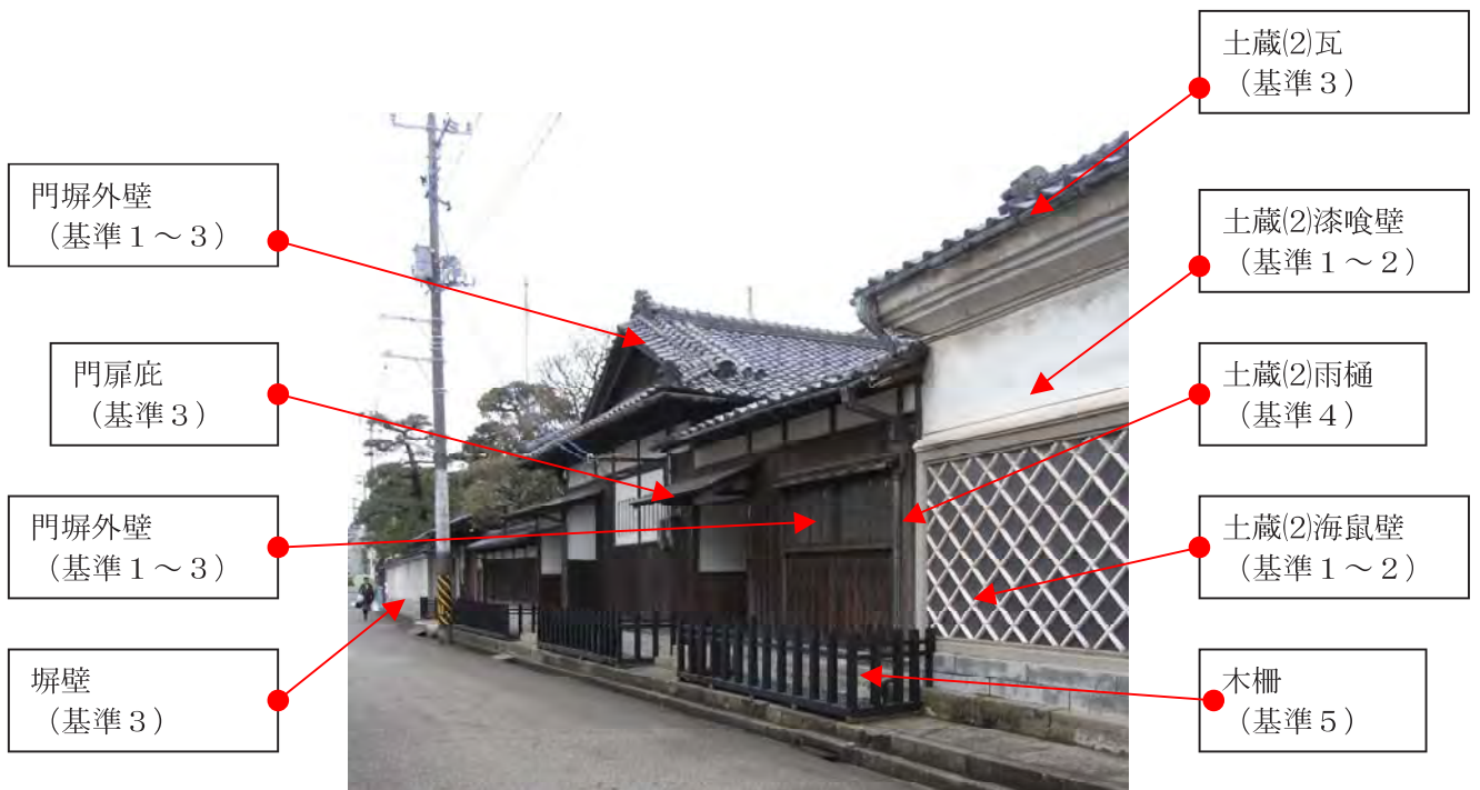
主屋・土蔵(2)東側外観
