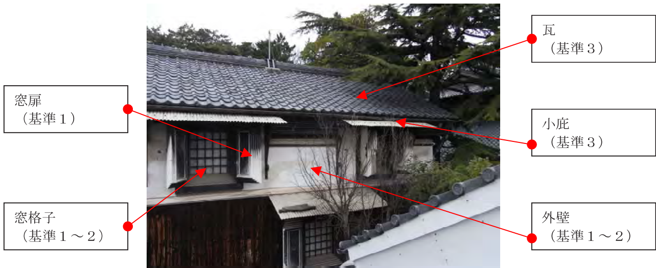
土蔵(1)南側外観
