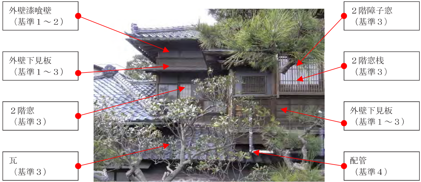
主屋2階南側外観
