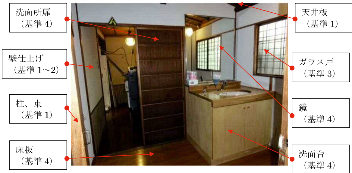
主屋 1 階事務室奥洗面所
