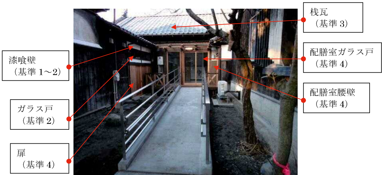
主屋東側外観
