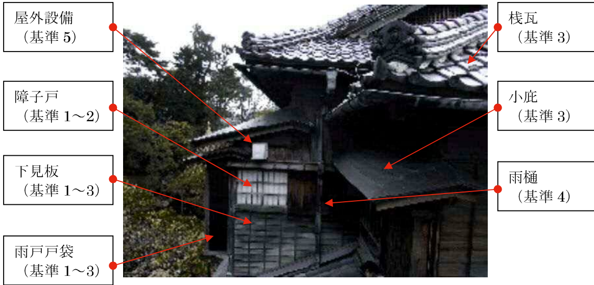
主屋 2 階西側外観
