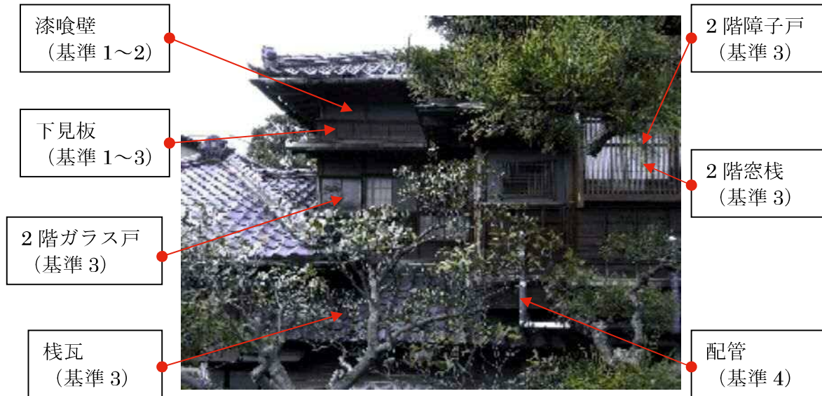
主屋 2階南側外観
