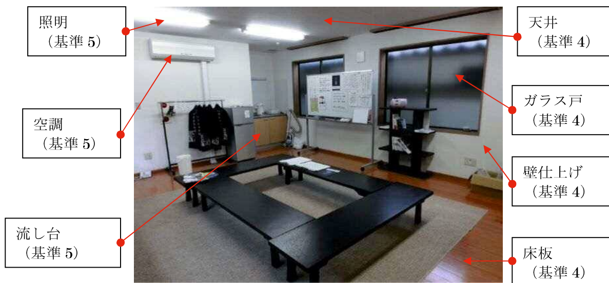
東側増築棟 2 階 (ボランティア室)
