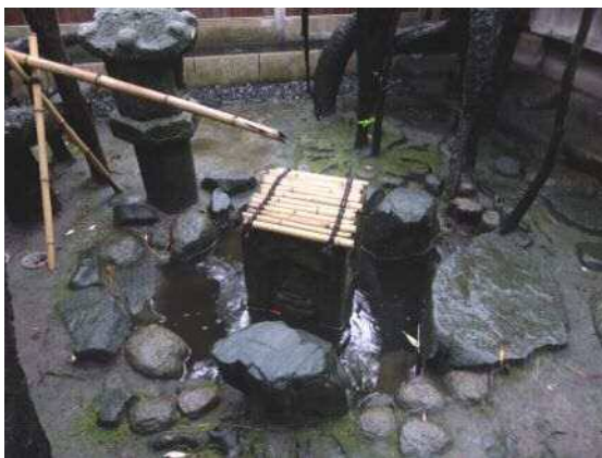
図4-9 蹲踞の排水不良
