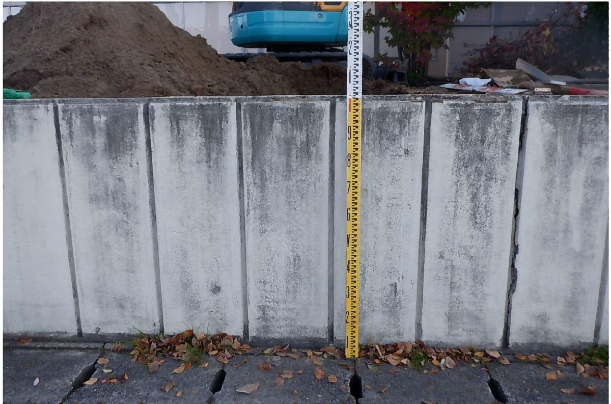
写真 4.6 市道側擁壁高 1.0m
