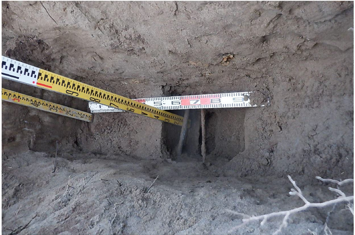
写真 4.4 基礎部高さ 0.3m、脇に径 2cm の黒パイプあり。
