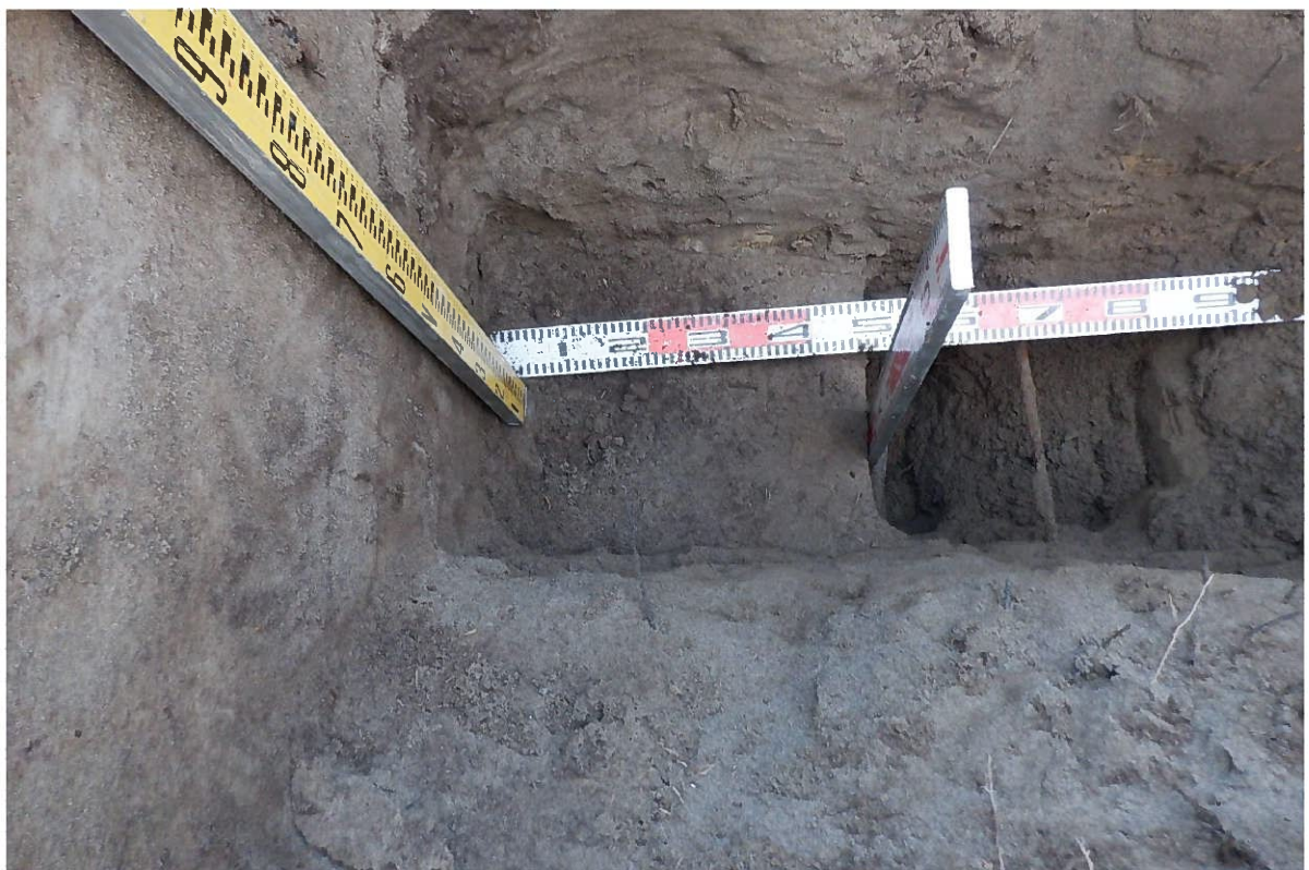
写真 4.3 基礎幅は壁幅 0.18\text{m} + 0.47\text{m} = 0.65\text{m}
