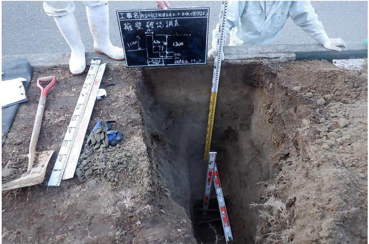
写真 4.2 擁壁形状確認
