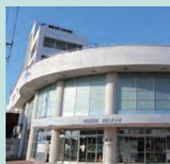
南口エントランス
