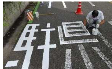
職員による道路標示補修
