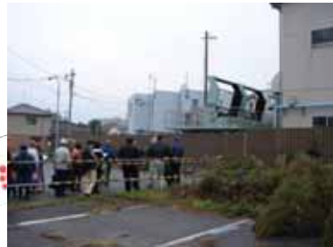
古信濃川排水機場
