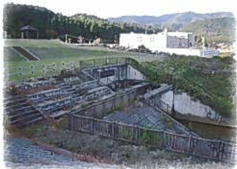
樋曾山隧道入口
