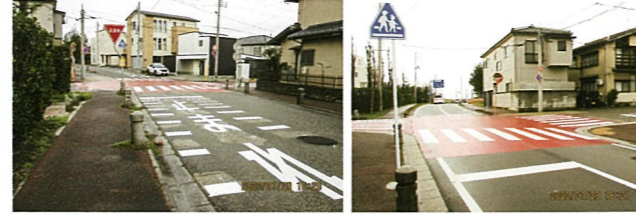
横断歩道の設置 (水戸地区)
