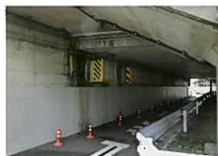
照明の暗いガード下
