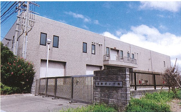
関新ポンプ場
