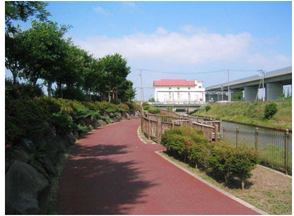
本所排水路 L=4,139m (遊歩道, 安全施設, 植栽等)
