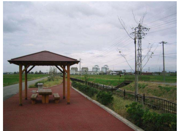
横江幹線用水路 L=1,253m (親水護岸, 遊歩道, 植栽等)
