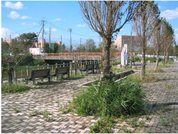
新堀排水路 L=815m (親水護岸, 修景水路, 植栽等)
