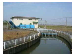
舞潟揚水機場
