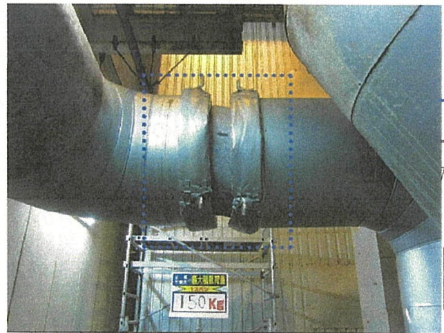
平成30年度補修済み （施工事例）
