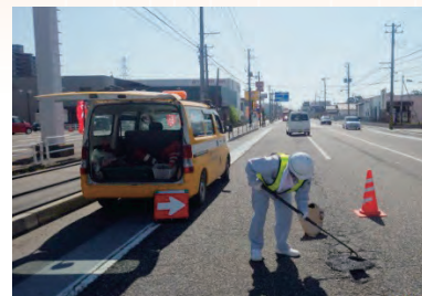
舗装補修の状況
