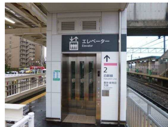
東新潟駅(H28改札内エレベーター整備)
