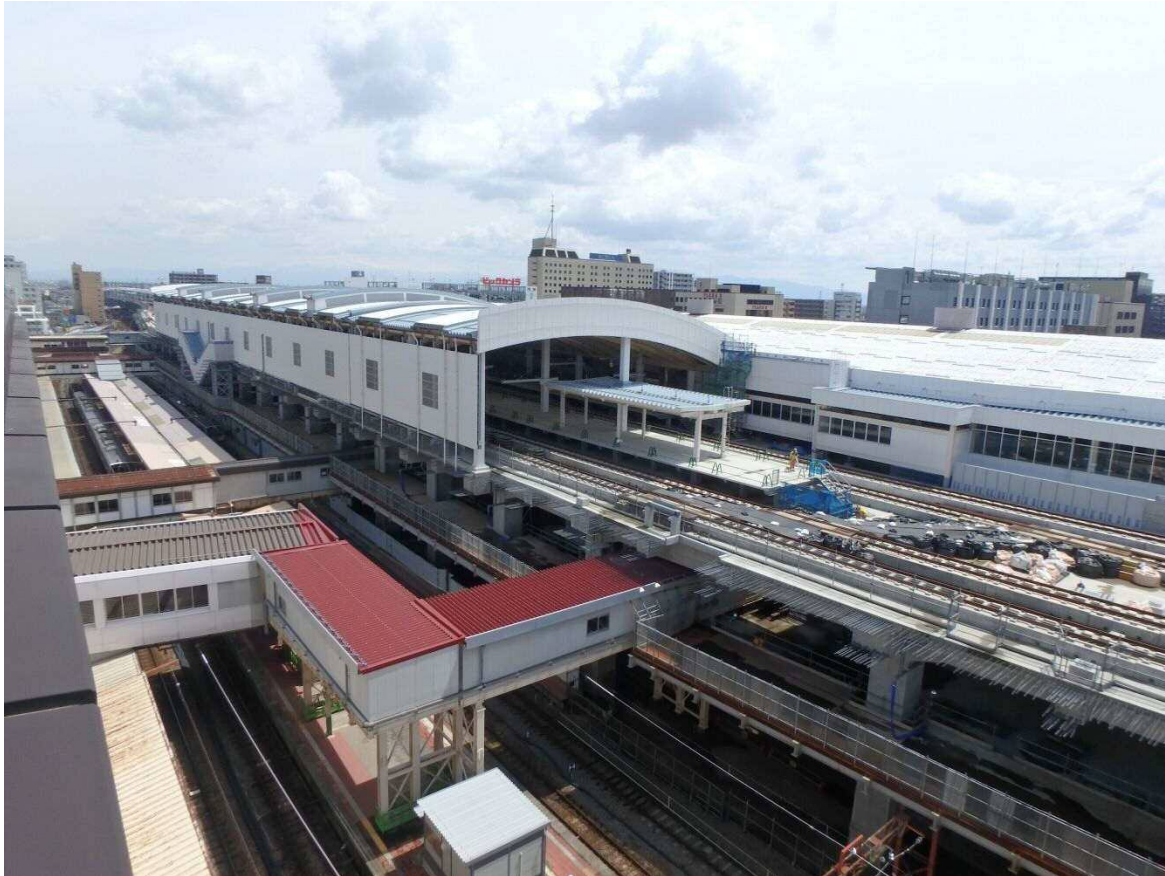
新潟駅部の高架化工事
