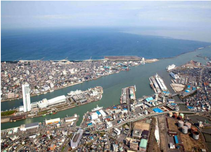
新潟港（西港区）
