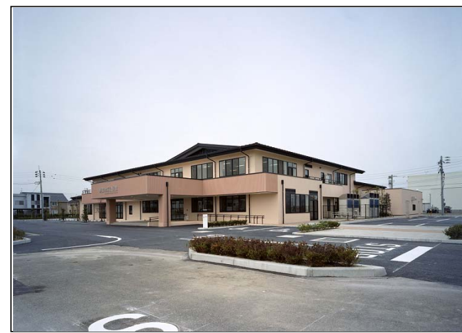
横越地区公民館(平成22年3月竣工)
